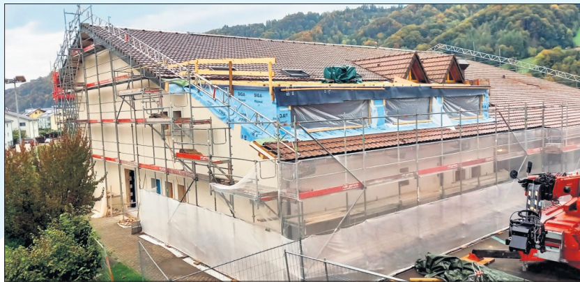
Bauarbeiten bei der Rümlihalle Schachen.
