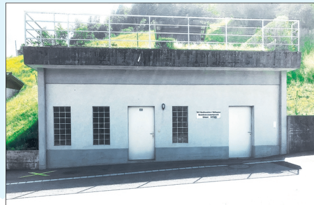
Grundwasserpumpwerk Bergbogen der Wasserversorgung Werthenstein.
