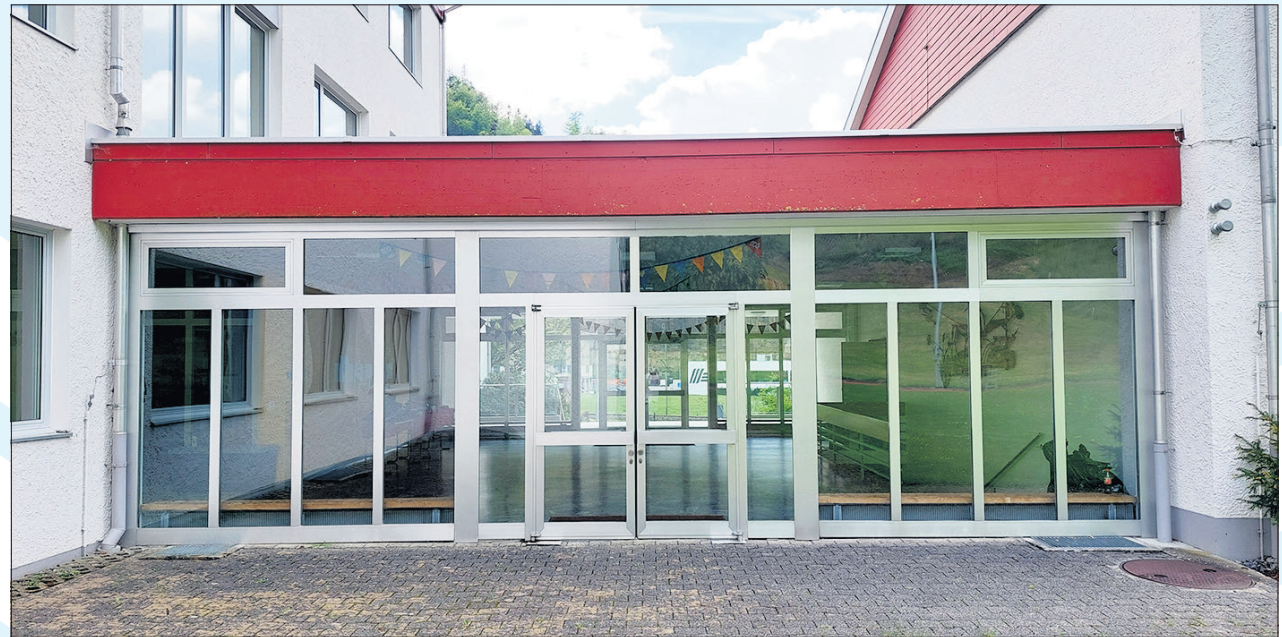
Die Glasfronten beim Schulhaus Markt werden ersetzt.
