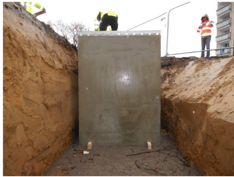
Einbau Betonschacht
